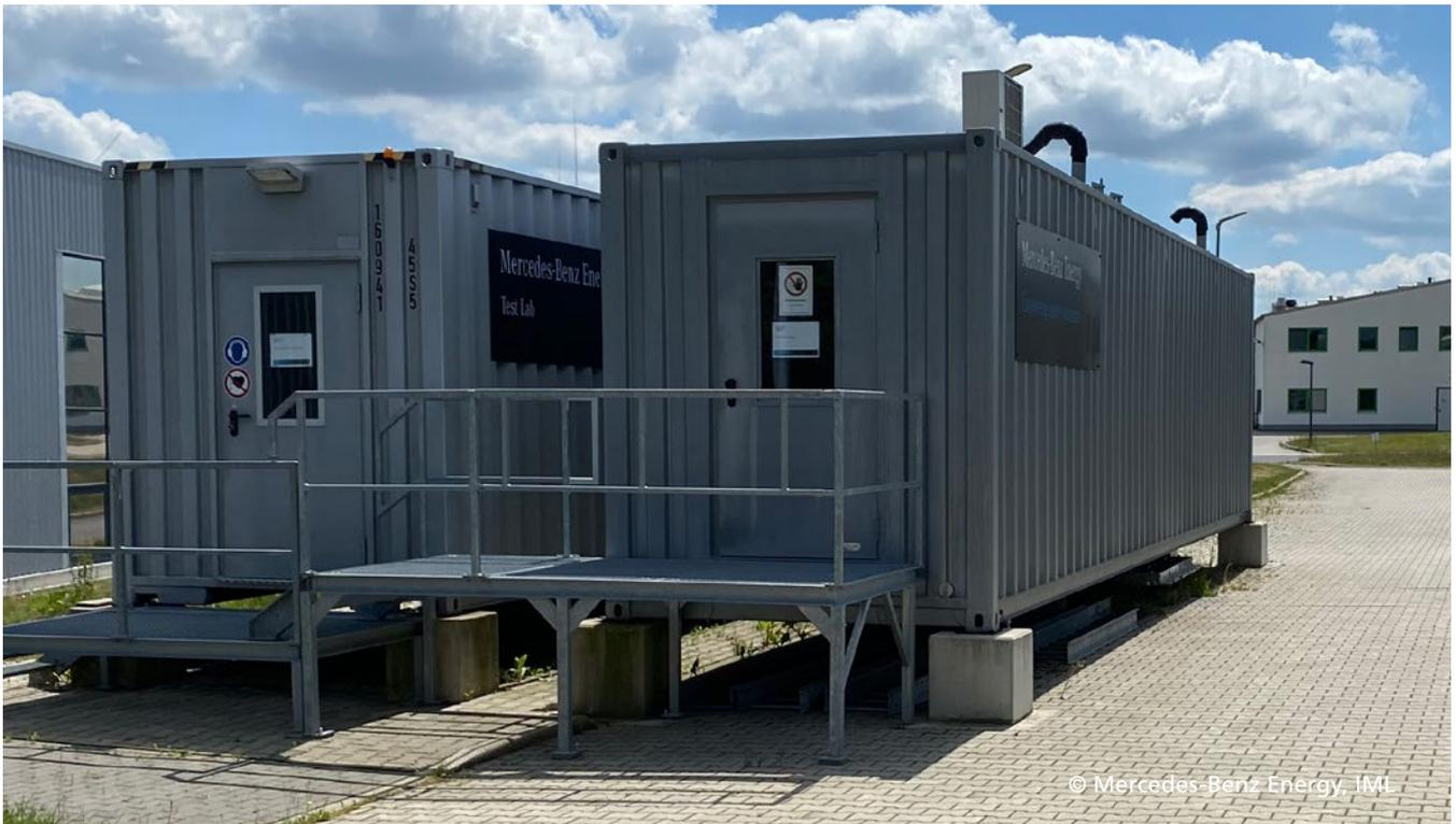
Abbildung 26: Stationärer Energiespeicher
