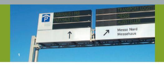
Dynamischer Anzeigenquerschnitt zur Verkehrslenkung
