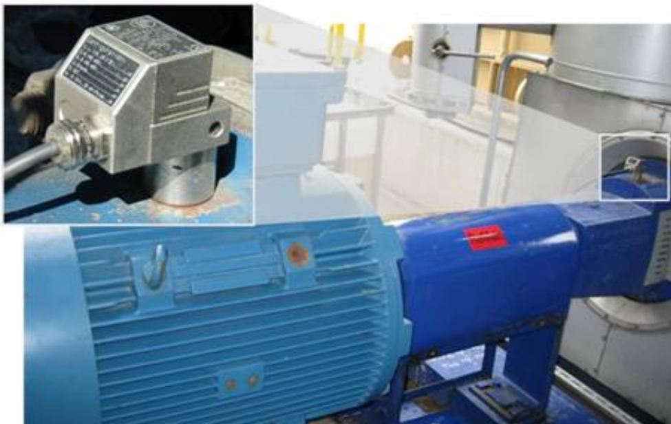
**Abb. 58: Schwingungssensor auf Pumpengehäuse**
